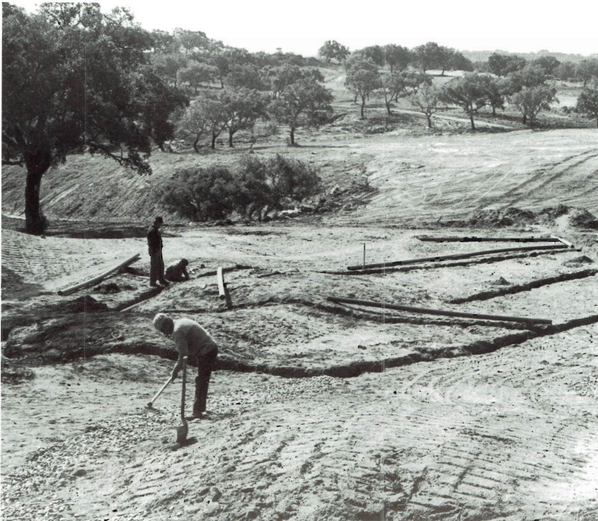
CONSTRUCCIÓN DEL GOLF VALDERRAMA / VADERRAMA'S GOLF COURSE UNDER CONSTRUCTION PÁGINA DERECHA: CONSTRUCCIÓN BUNGALOW CLUB DE GOLF / RIGHT PAGE: THE GOLF CLUB'S BUNGALOWS UNDER CONSTRUCTION
